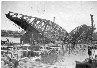
Мост через р. Великую, разрушенный немцами при отступлении. г. Псков
