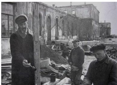
Восстановление железнодорожного вокзала. г. Псков
