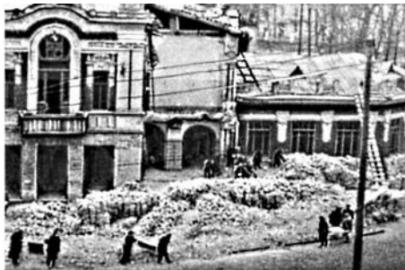
Разрушенное здание Псковского театра им. А.С. Пушкина
